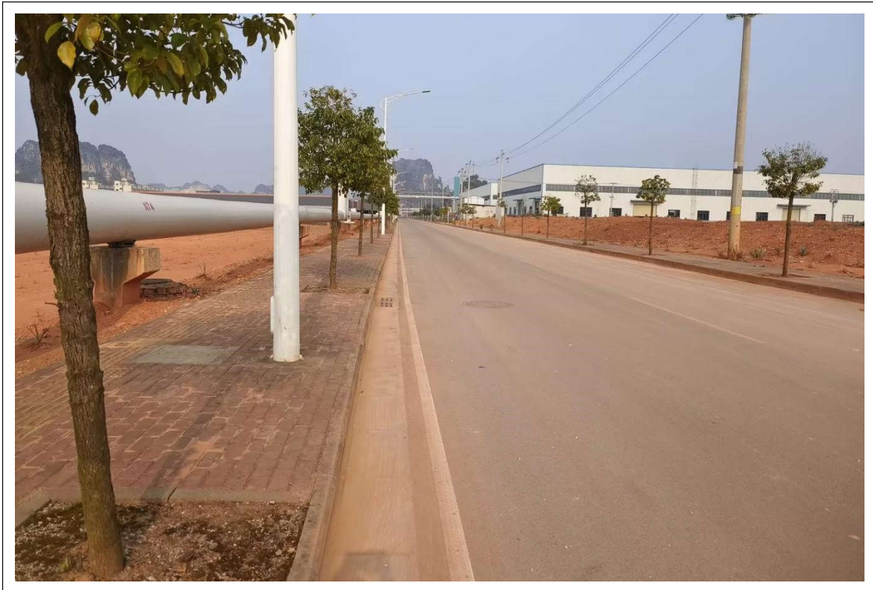
项目进场道路（拍摄于2024年3月）
