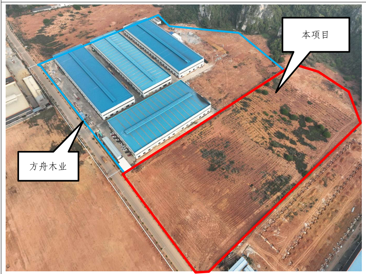
方舟木业地块现状（拍摄于2024年3月）
