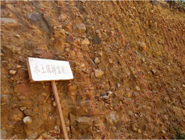
道路工程区水土保持监测点现状 (1#)
