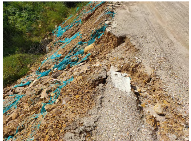
道路工程区新建道路轻微垮塌现状
