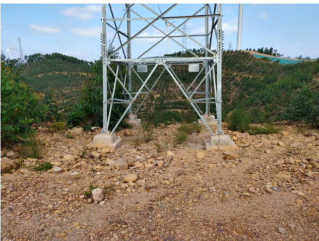
集电线路区铁塔基础植被恢复现状（三）
