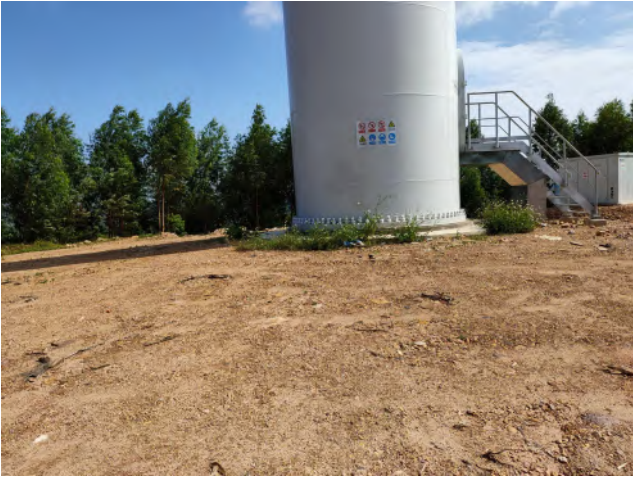
风力发电场区风机平台裸露现状
