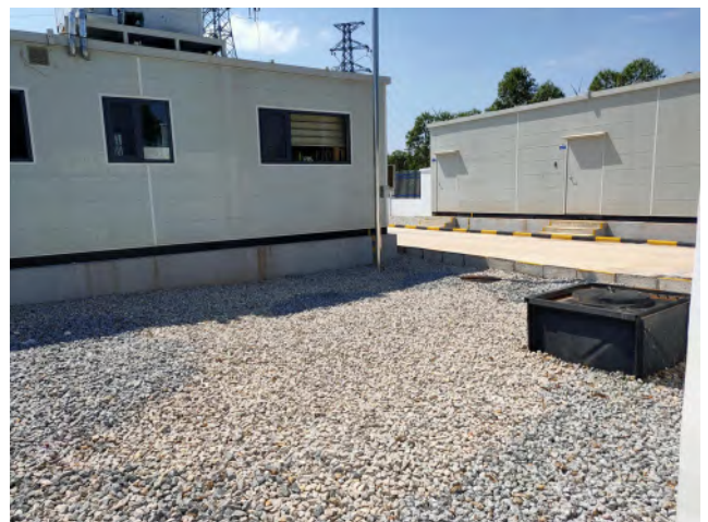
升压站现状（二）
