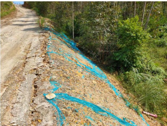
道路工程区新建道路下边坡无纺布损毁严重
