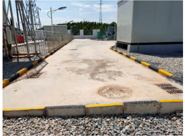
升压站现状（四）
