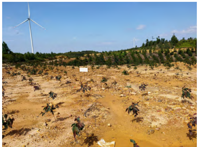
风力发电场区风机平台绿化现状
