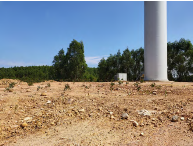
风力发电场区风机平台绿化现状
