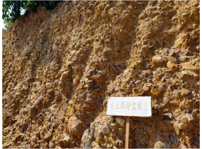
道路工程区水土保持监测点现状 (2#)
