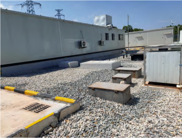
升压站现状（三）
