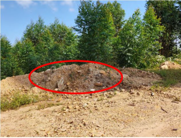
临时堆土场区临时堆土现状
