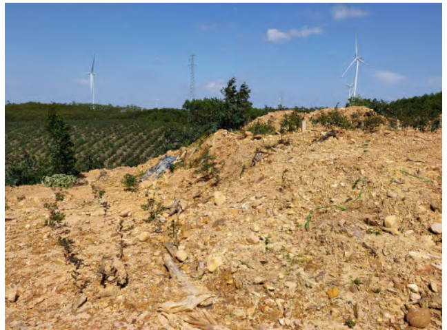
风力发电区风机平台边坡绿化现状
