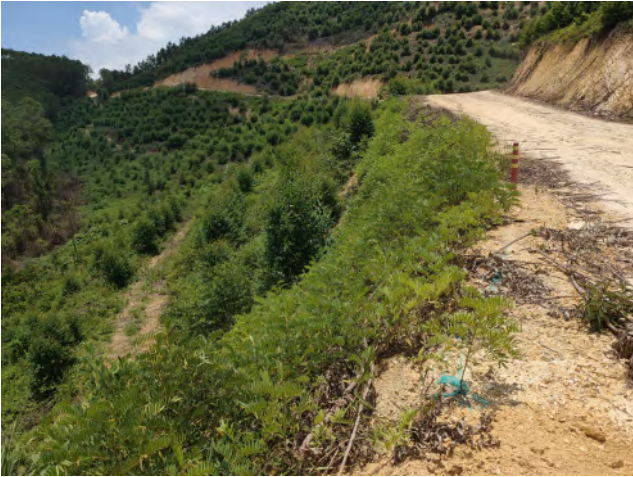
道路工程区新建道路下边坡绿化现状
