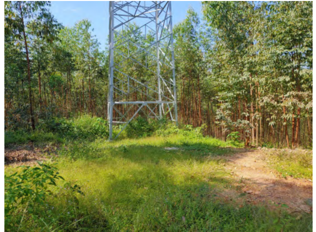
集电线路区铁塔基础植被恢复现状（二）
