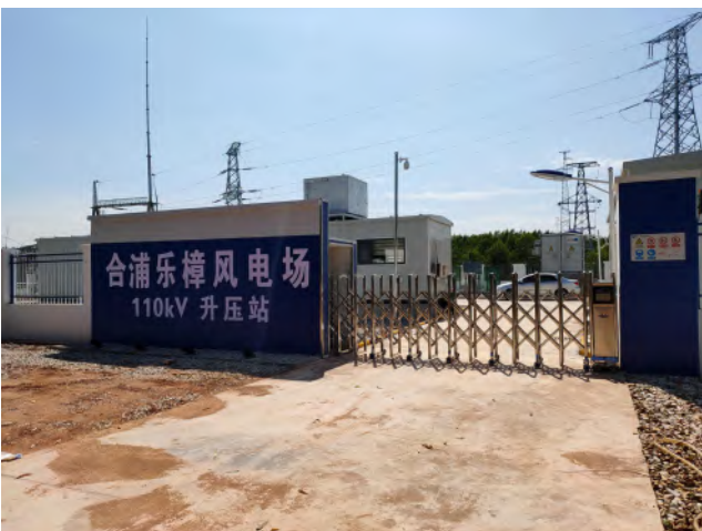
升压站现状（一）
