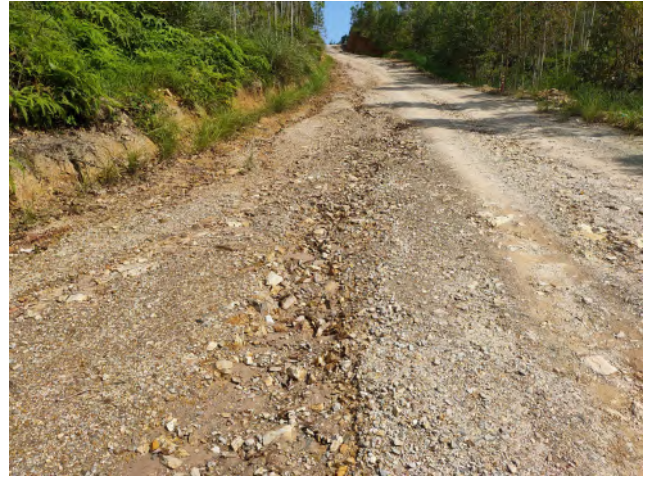
道路工程区路面冲沟现状
