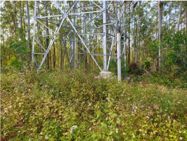
集电线路区铁塔基础植被恢复现状（一）
