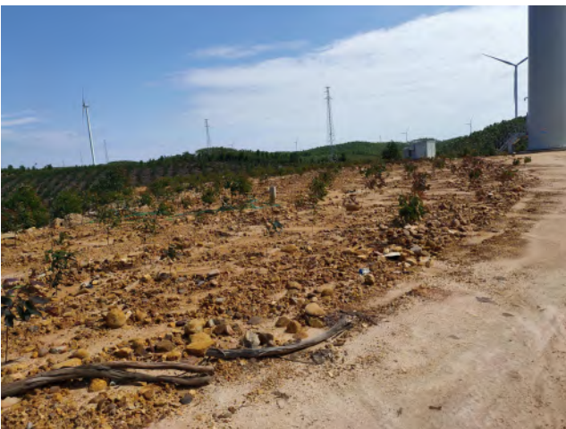
风力发电场区风机平台绿化现状
