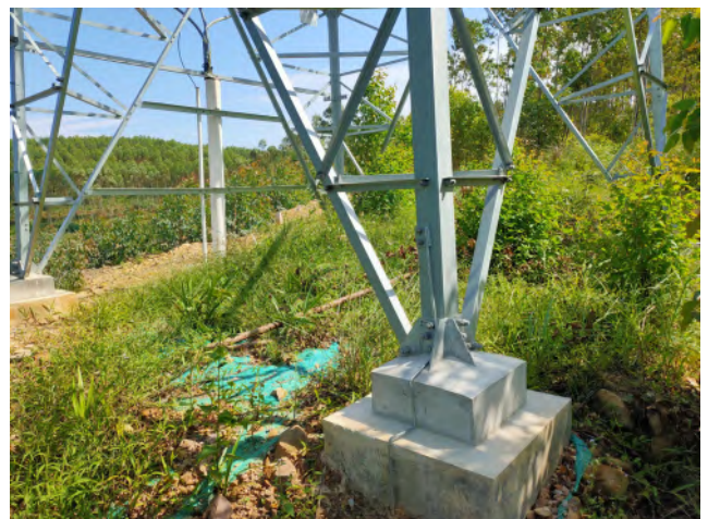
集电线路区铁塔基础植被恢复现状（四）
